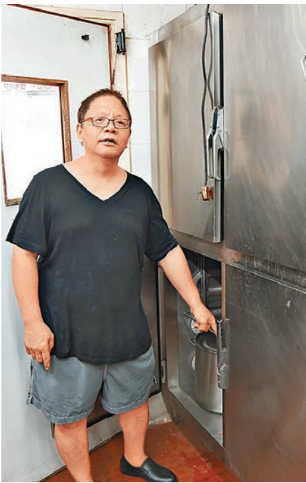
為傷者急救的劉先生，講述令廚工工人觸電昏迷的雪櫃。
