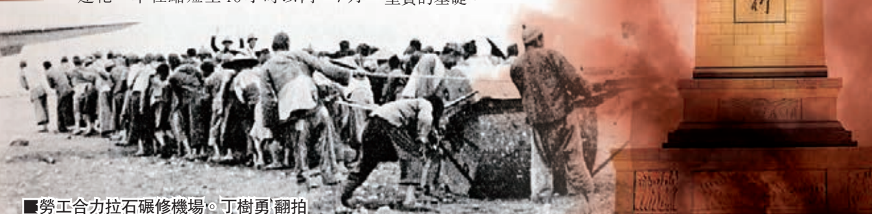
勞工合力拉石碾修機場。丁樹勇翻拍
