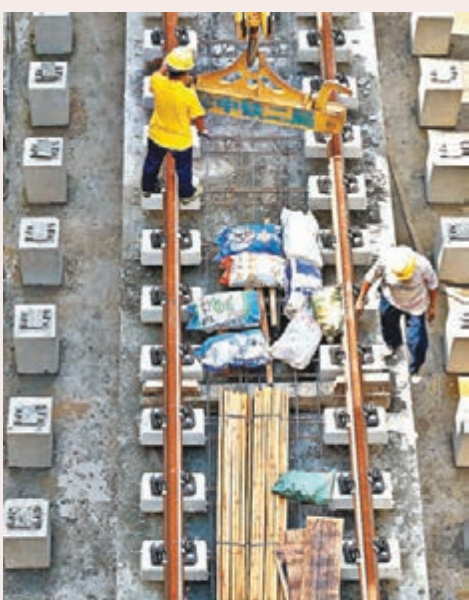
■工人在深圳地鐵9號線筆架山公園鋪設基礎準備鋪設軌道。 本報深圳傳真
