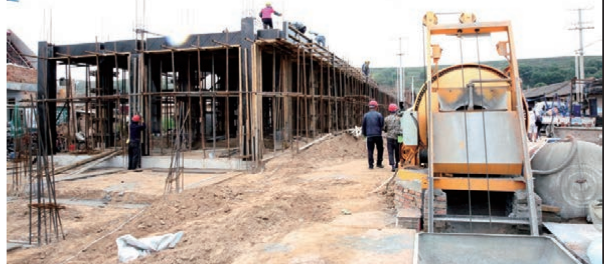
■柯寨村移民搬遷工程正在修建中。
