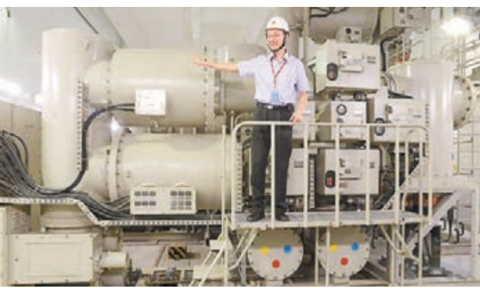
陳子峰指身後的「氣體絕緣開關裝置」遇上切斷電源時,一台裝置即使關閉,另一台都會繼續運作。 梁祖彝攝
