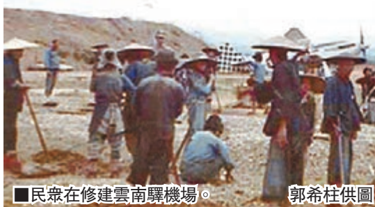
■民眾在修建雲南南驛機場。 郭希柱供圖
