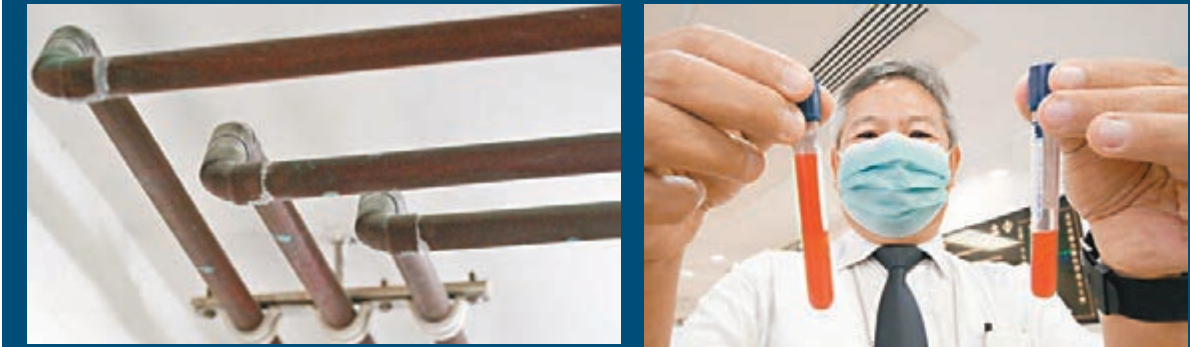
■目前食水含鉛的最大源頭被指是水管接駁位焊料。 資料圖片
