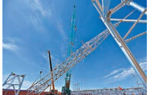
■新疆五彩灣750千伏變電站750構架首基吊裝。 本報新疆傳真
