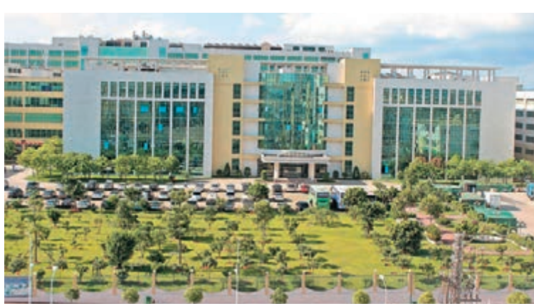
■ 伯恩光學惠州工業園中央寫字樓
