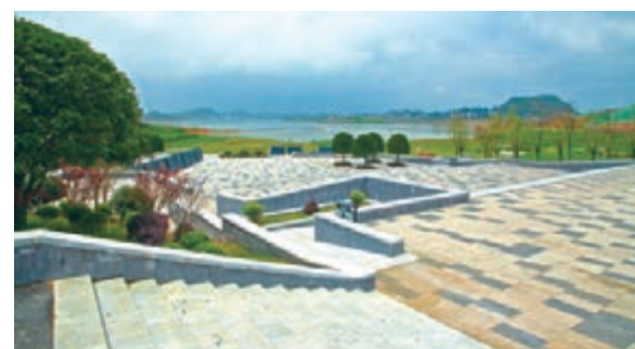
■「貴安新區的生態砂基透水系統具有透水速率快、保水性能好、保水率高、濾水性強的特點……」月亮湖畔生態砂基雨水收集與利用系統是其標誌項目。
