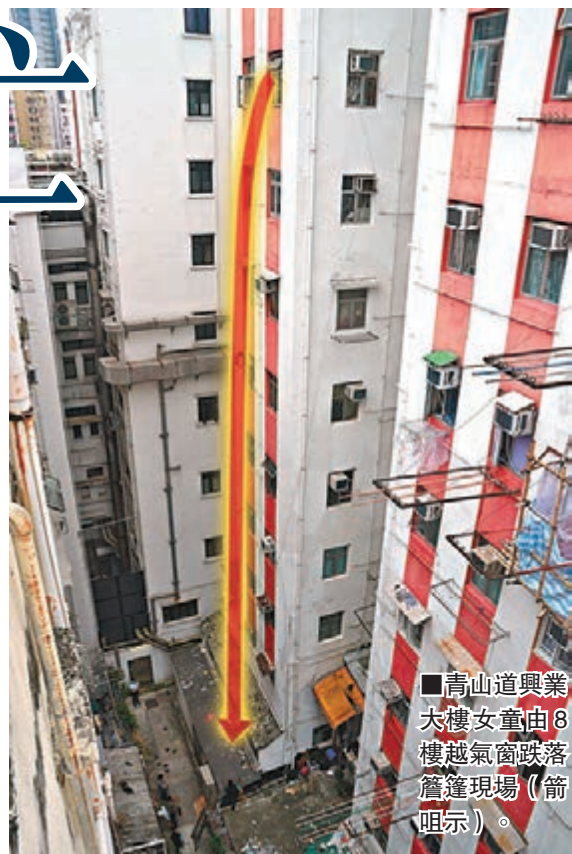
青山道興業大樓女童由8樓越氣窗墮落簷篷現場（箭咀示）。
