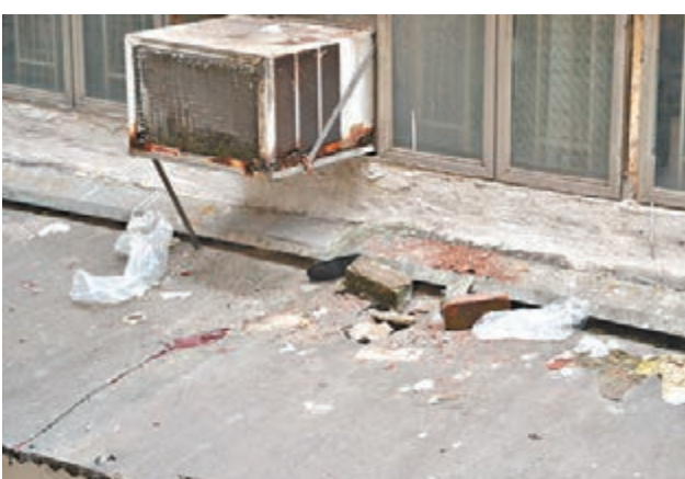
墮樓女童跌落大廈近後巷簷篷之處明顯被壓凹。
