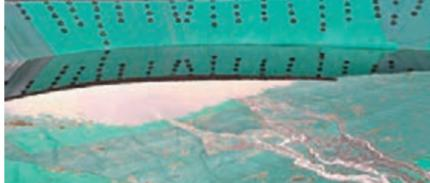
■打鼓嶺堆填區其中一個臨時污水儲存池於前年出現裂縫,現時已完成修補。
