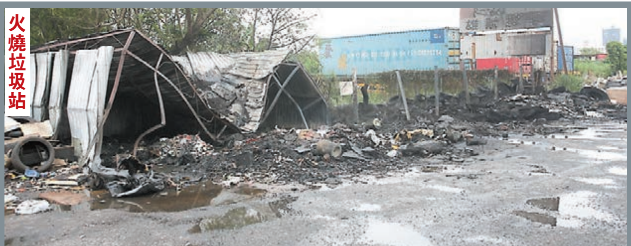
元朗新田米埔青山公路101號一個垃圾收集站，昨晨8時許有一批廢棄輪胎突然冒煙起火，一時黑煙席捲半空，陣陣刺鼻氣味籠罩附近村屋，村民發現立即報警，部分村民更慌忙自行疏散離開村屋暫避。大批消防員接報到場，出動兩隊煙帽隊及開動兩條喉灌救，約半小時後將火救熄，火警中幸無人受傷，起因有待調查。
