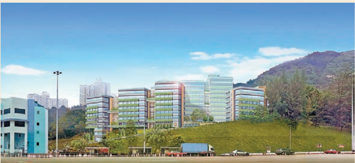
■王歐陽(香港)有限公司 Residence Hall
