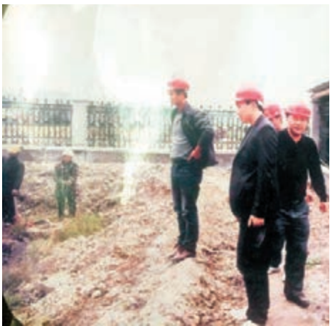
■陳昆(前)在建設中的污水廠工地察看。
