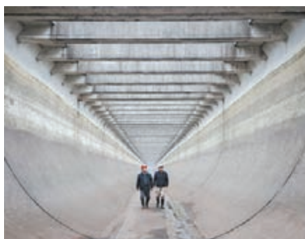
停水檢修期間，工作人員在金湖渡槽內部檢查供水設施。
