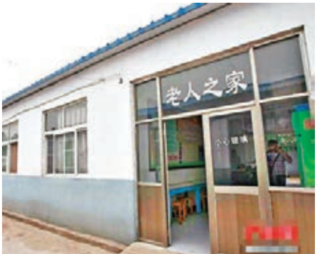
■未起火時老年公寓房屋結構。網上圖片
