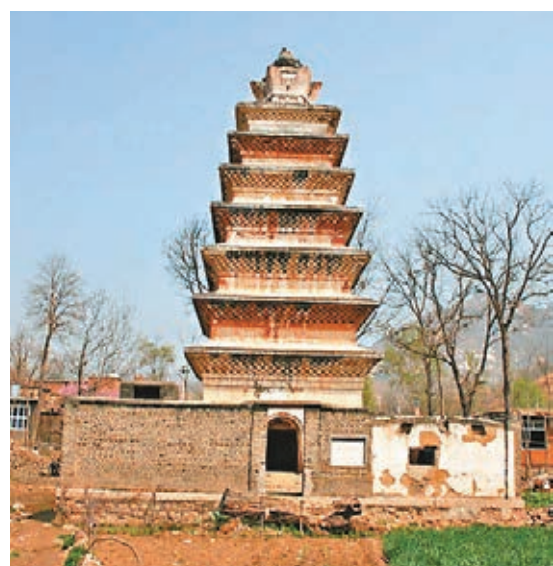
■修繕前的河北省靈壽縣幽居寺塔。本報河北傳真
