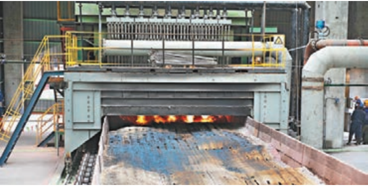
■青鋼集團1#燒結工程240m²熱負荷試車現場。本報青島傳真
