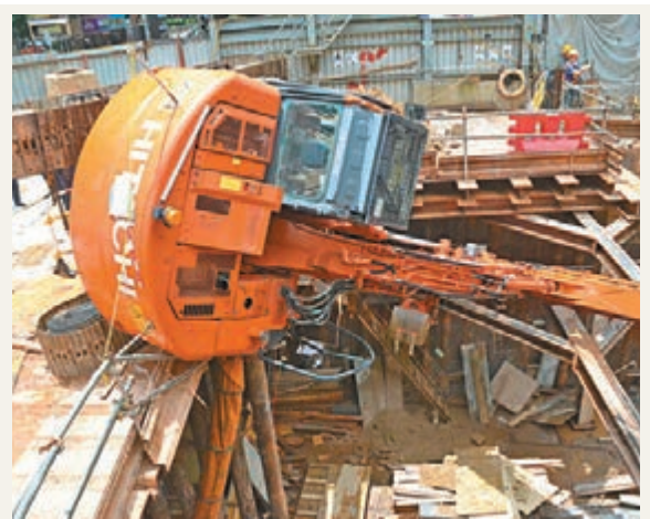
發生翻側壓傷工人的吊臂挖泥車險告跌落坑洞。
