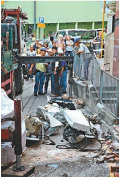
■在斷纜後由22樓直墜毀爛冷氣組件。
