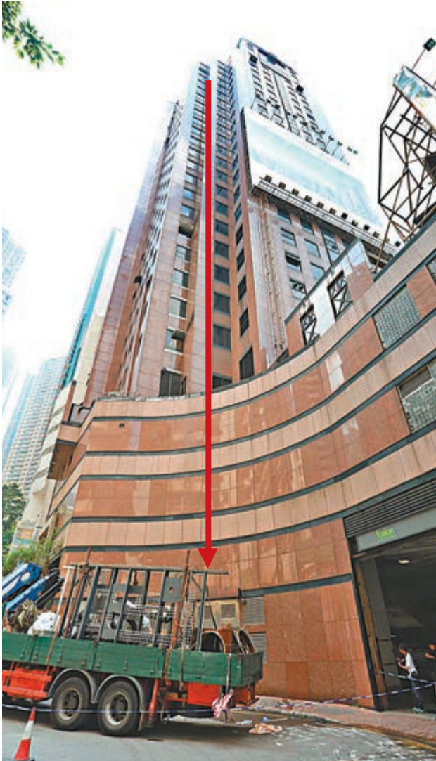
■科達中心發生重半噸冷氣組件被吊至22樓期間斷纜直墜地面毀毀(箭咀示)。
