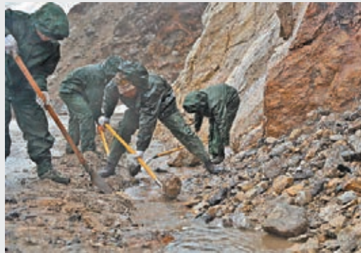
■武警西藏總隊聶拉木縣中隊官兵冒雨清理排水渠，保障「生命通道」暢通。新華社
