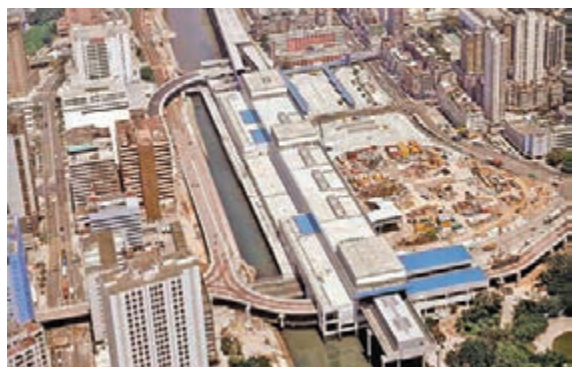
■香港屯門西鐵站項目
