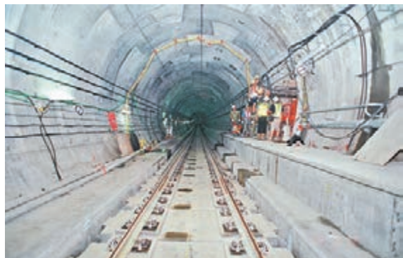
■九龍南環線工程KSR910項目
