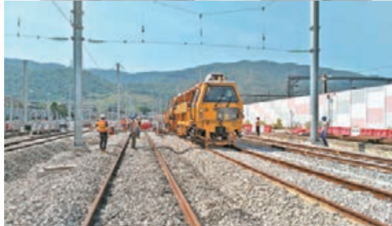
■香港鐵路道碴填固項目
