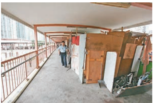
欽州西街天橋搭建多間板間房。
