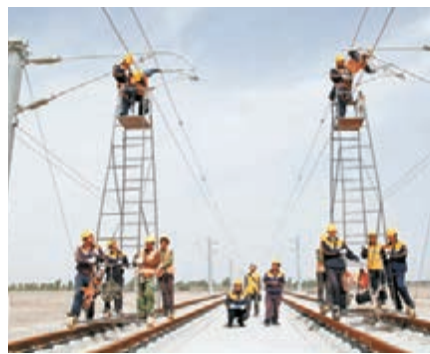
內地鐵路對外開放進一步擴大。圖為技術人員對電氣化鐵路接觸網進行檢測。資料圖片
