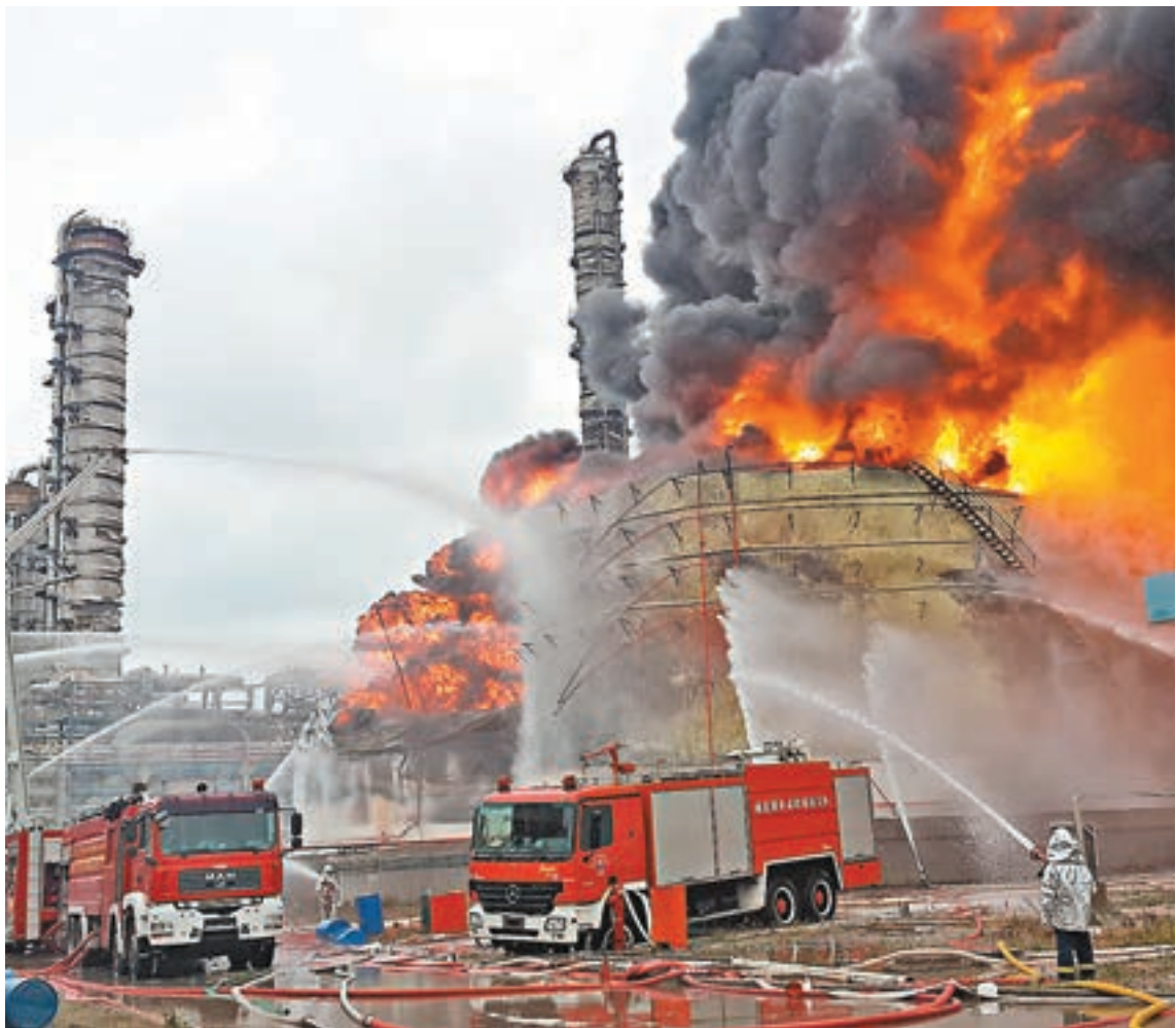
■消防力量正在全力撲救起火的第四個儲罐。
