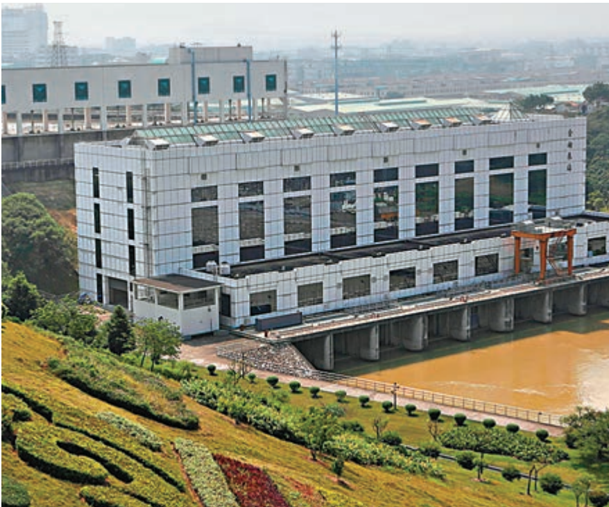
圖為東深供水工程項目——廣東省東莞市金湖泵站。
