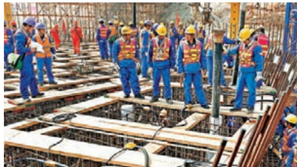
■紅沿河核電站5號機組正式開工建設。 中新社
