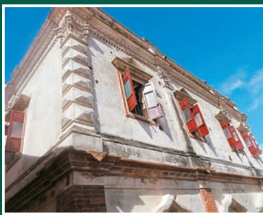
■北山洋樓牆上仍留下彈孔。
