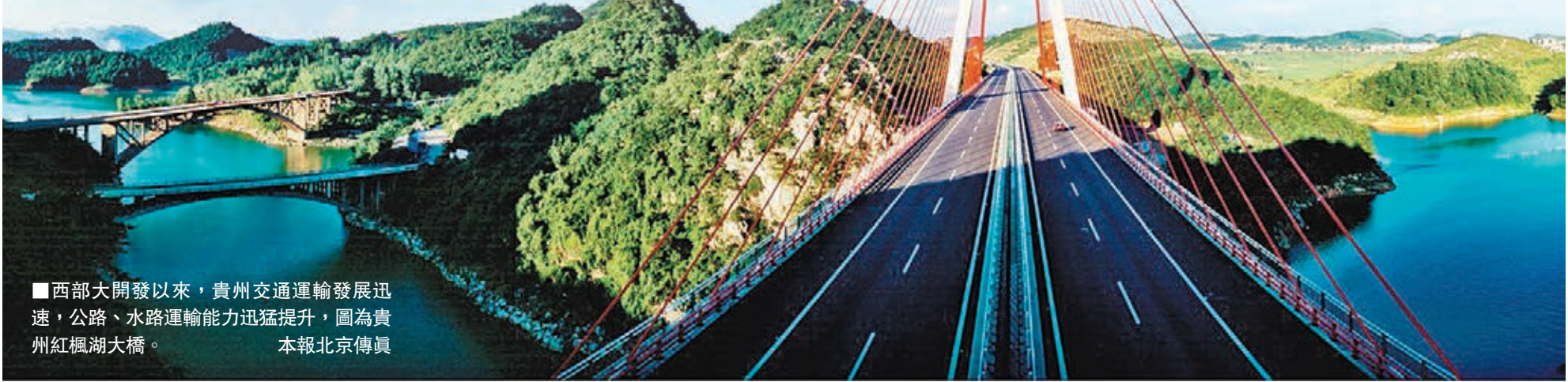
■西部大開發以來，貴州交通運輸發展迅速，公路、水路運輸能力迅猛提升，圖為貴州紅楓湖大橋。 本報北京傳真
