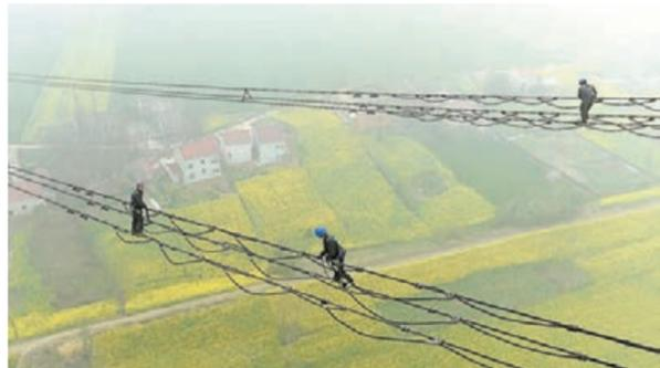
湖北 高空走電線 國家電網公司湖北電力檢修公司鄂西北運維分部的檢修工昨日在漢江大跨越導線上進行走線檢查。檢修工在距地面約122米的高空導線上行走，檢查各式高空電力設備運行情況，並對隱患及時處理。 華新報
