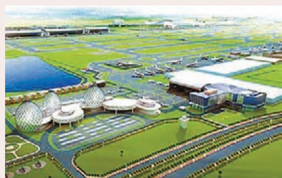
■寧波杭州灣新區通航機場效果圖。未來將實現通航產業整體產值超1,000億元。
