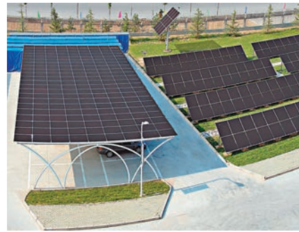
■河北建設的光伏電站。 本報河北傳真
