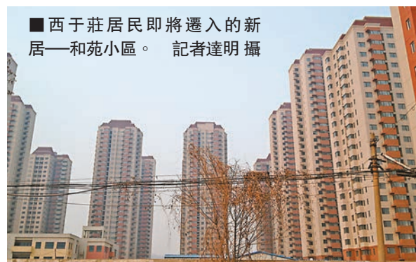
西于莊居民即將遷入的新居——和苑小區。
