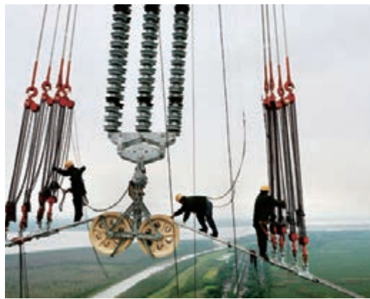
建設中的特高壓電網
