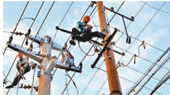
內蒙古成為內地第二個進行輸配電價改革的試驗田。圖為工作人員高空作業。網上圖片
