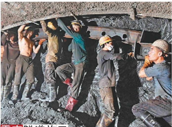
雲南隧道施工
