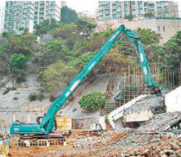
■工程團隊以長臂油壓破碎機，全日24小時進行拆卸工程，成功縮短施工時間。金門建築供圖 架次泥頭車進出工地和當區路面行駛。有達70%泥石亦可用於本港的填海工程，作循環再用。 他又透露，工程團隊在拆卸香港大學黃克競樓樓梯時，原來計劃施工時間長達3個月，但與港大協調後，他們趁學校和公眾假期實施封路措施，並以長臂油壓破碎機，全日24小時進行拆卸工程，免卻建造臨時結構工序，最後成功將施工時間縮短至3天。 而為保育堅尼地城站附近有達百年歷史的樹牆，工程團隊亦聘請獨立樹木專家，監察保育計劃，又為樹牆設置臨時支架，並將地下水維持正常水平，以免樹牆在隧道開挖時受到影響。
