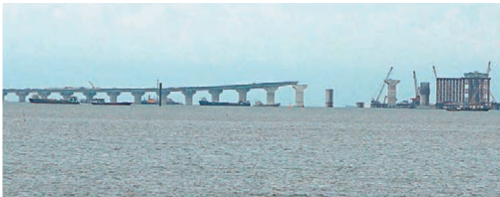
張炳良表示,10份工程合約已有7份回標,金額佔總工程費用90%,故追加的撥款金額是準確可信。圖為興建中的港珠澳大橋。
