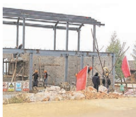
■災區民衆正在建蓋新屋。 記者李艷娟 攝
