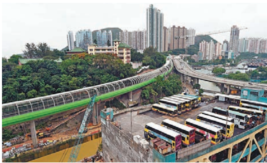
政府表示南港島線2016年通車或面臨極大風險。圖為較早前南港島黃竹坑施工現場。資料圖片
