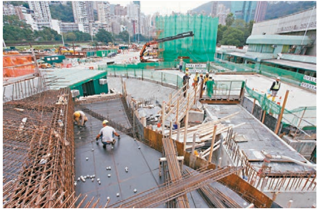
跑馬地蓄洪池容量相當於24個游泳池,工程需要在地下鋪設箱形暗渠。黃偉邦 攝
