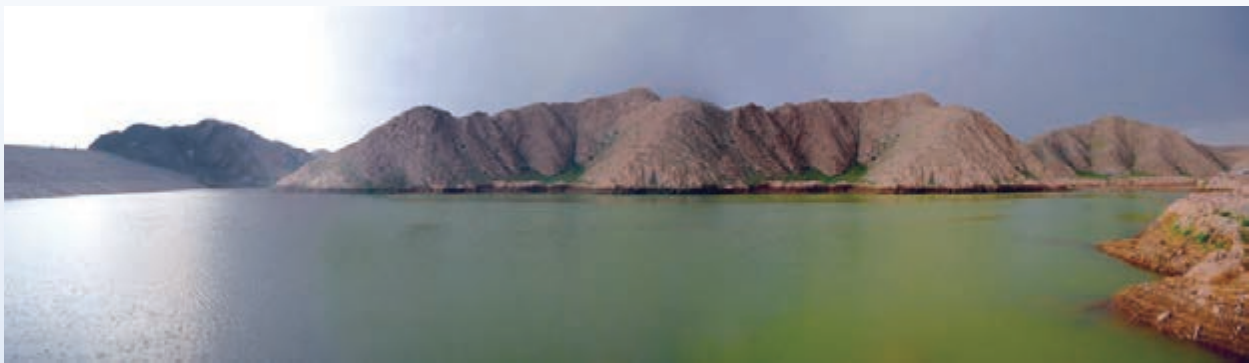
■石門溝水庫儲水量達630萬m³，是「引大入秦」工程蘭州新區專用供水項目。
