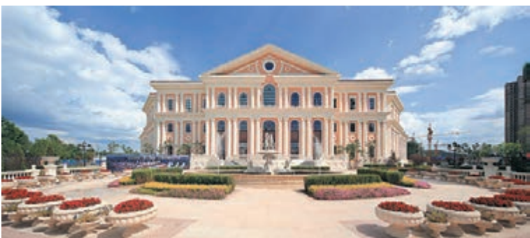
「星悅南岸」工程進展順利,展示廳及相關設施相繼落成。
