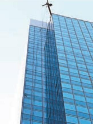
■大廈高層最少有3幅玻璃幕牆被吊船撞毀。
