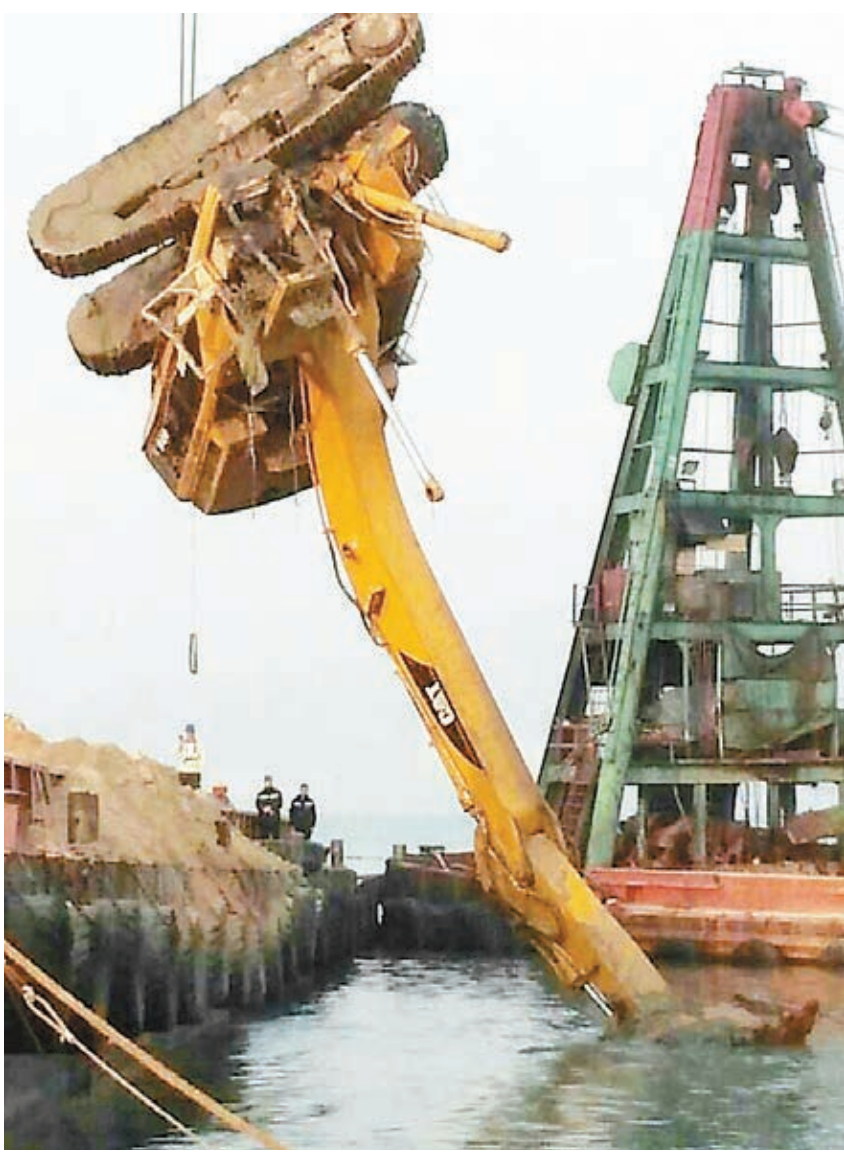
■墮海挖泥機被吊起時機身滿布淤泥。
