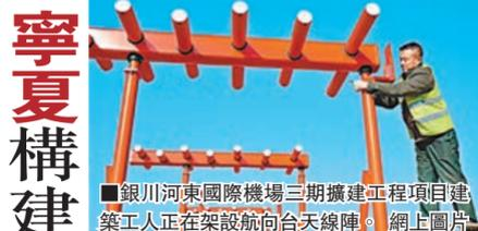
銀川河東國際機場三期擴建工程項目建築工人正在架設航向台天線陣。網上圖片
