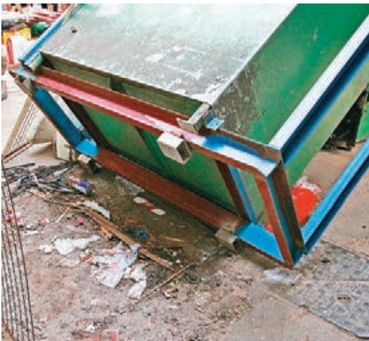
▲排檔四周加裝了藍色的工字鐵，相信用作方便吊起搬移。
