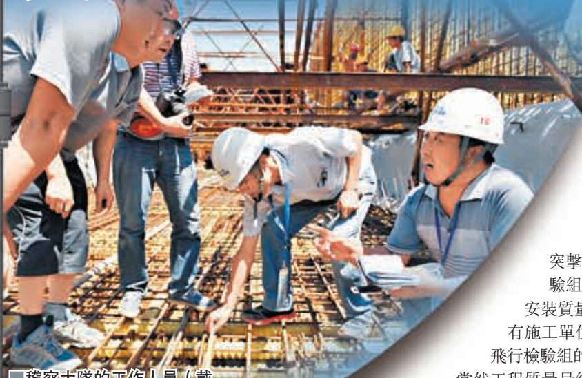
■稽察大隊的工作人員(戴白色安全帽者)在測量鋼筋的間距是否符合要求。資料圖片
