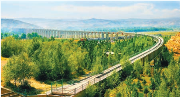
■引入大秦渡槽。
